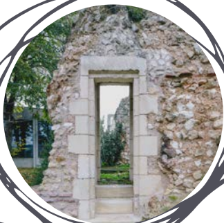
Rempart antique du 4 e siècle, Beauvais, L. Kronental
